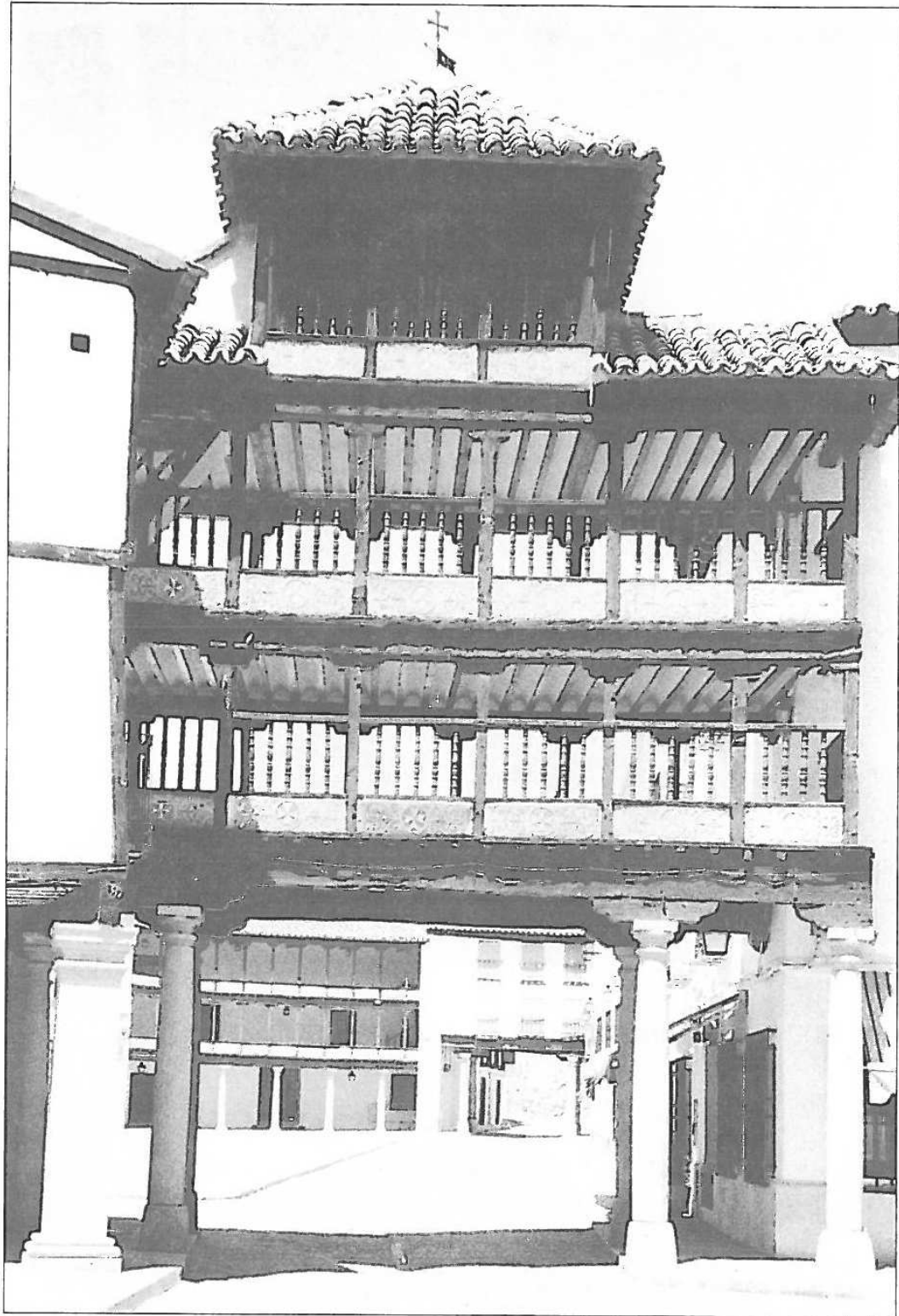
Plaza Mayor de Tembleque (Arco Principal). Una de las más bellas y originales de España. De planta cuadrada, soportada en tres de sus costados a base de columnas toscanas y de dos cuerpos de galerías cuyos antepechos están decorados con las cruces de la Orden de San Juan. Tembleque (Toledo). ESPAÑA.
